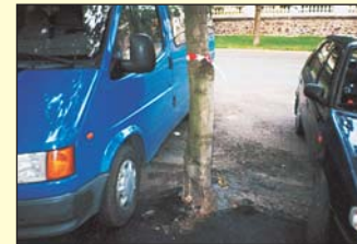
Na některých místech Teplic to nemají jednoduché ani nově vysazené stromy. Jako otřesný příklad lze uvést jeden z kaštanů ve Vrchlického ulici sevřený nánošy asfaltu a rovněž parkujícími automobily. Tak tomu se tedy říká „péče o stromy“.
