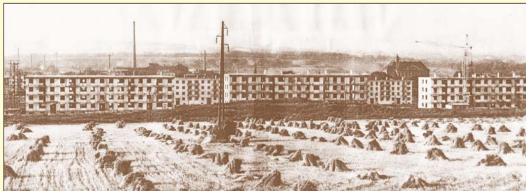
Snímek z roku 1960 pořízený od jihu směrem k severu zachytil výstavbu řetenického sídliště. Tehdejší okolí ještě obklopovala pole.
