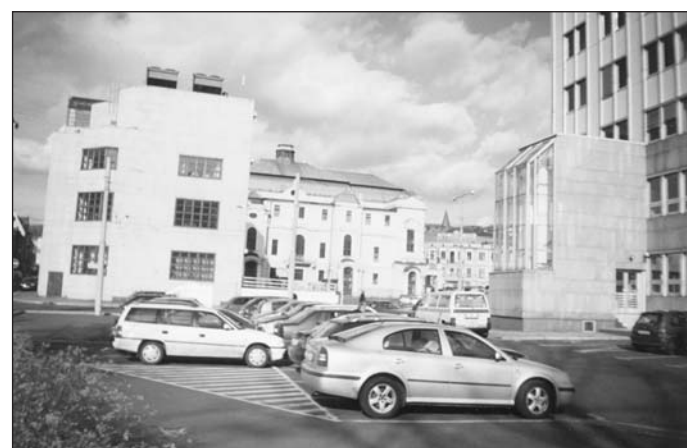
Pohled směrem od jihu na část Městského divadla v Ústí n. L. i s přístavbou nové provozní budovy.
