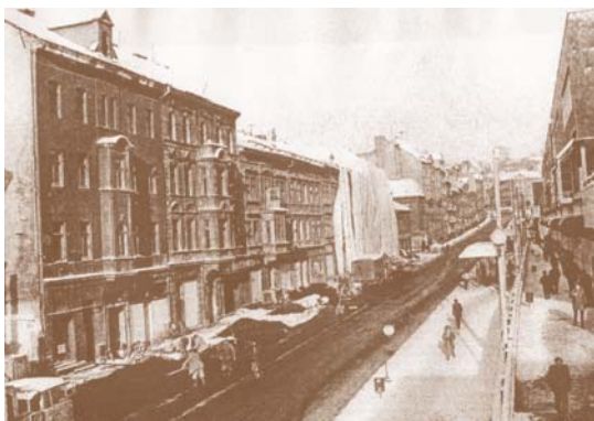
Demolice zástavby Fučikovy, dnešní Masarykovy ulice v zimě roku 1980.
