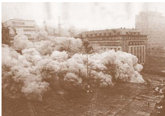
Demolice budovy okresního soudu na Mírovém náměstí 14. ledna 1976.
