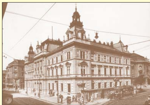
Budova ústecké hlavní pošty, která byla postavena a otevřena v roce 1900 a zbourána roku 1988. Snímek pochází z doby kolem roku 1925
