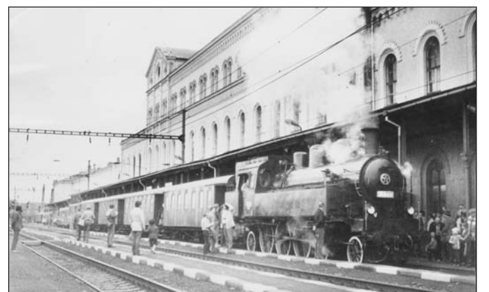
Pohled z kolejiště hlavního nádraží směrem k nástupišti a odbavovací budově. Na první koleji stojí ještě starý typ parního vlaku připravený k mimořádné jízdě v roce 1987.
