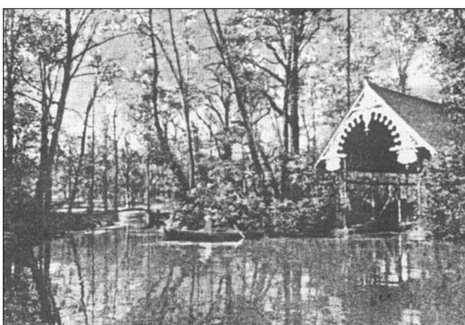
Lodkám v Zámecké zahradě sloužil ještě i krátce po druhé světové válce za přístaviště dřevěný přístřešek na západním okraji Horního rybníka. Tato stavba přežila až do dnešních časů.
