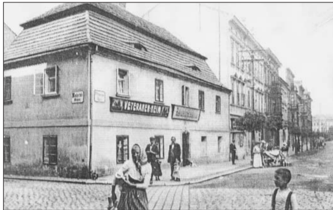
Budova hostince „Zum Scheckenthal“ pochází z roku 1798 a její snímek s přílehlou Pařížskou ulicí byl pořízen kolem roku 1910. Na jeho místě vznikla později dominantní budova, v jejímž přízemí se nacházela kavárna „Savoy“. Ta sloužila ještě v devadesátých letech 20. století, ovšem dnes zde naleznete Raiffeisenbank.
