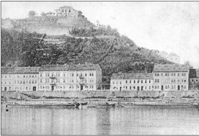
Jeden z nejstarších fotografických snímků z doby kolem roku 1870 zachycuje domy v Labské, později Pražské ulici. Nad nimi se tyčí Soudní vrch se stavbou restaurace a tanečního sálu z roku 1848, tehdy nazývané Ferdinandova výšina. Tento objekt byl zbořen roku 1896 a na jeho místě postavena Větruše.
