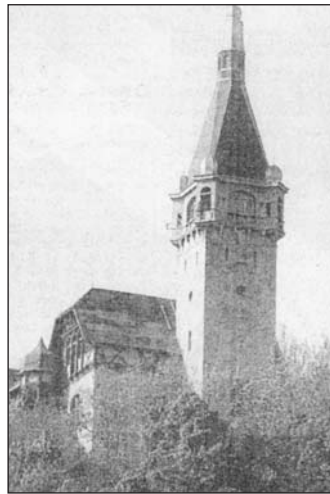
Ústecká dominanta Větruše na Soudním vrchu prochází v současnosti rozsáhlou rekonstrukcí a svým vzrůstem.
